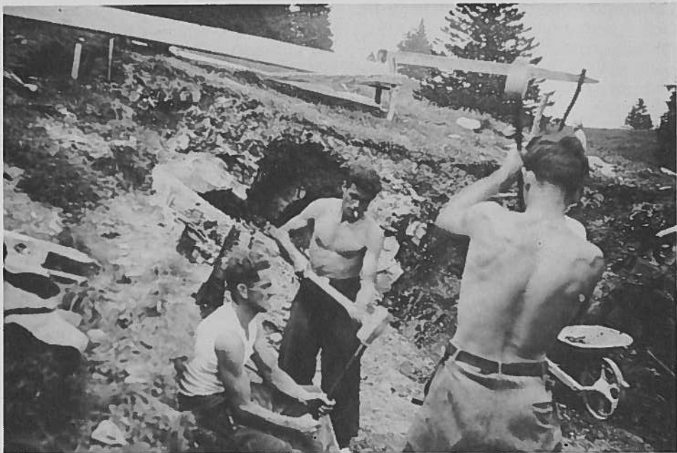
Schwerarbeit beim Aushub von der Skihütte! (links Hans Saxer, mitte Georg Schlegel)
