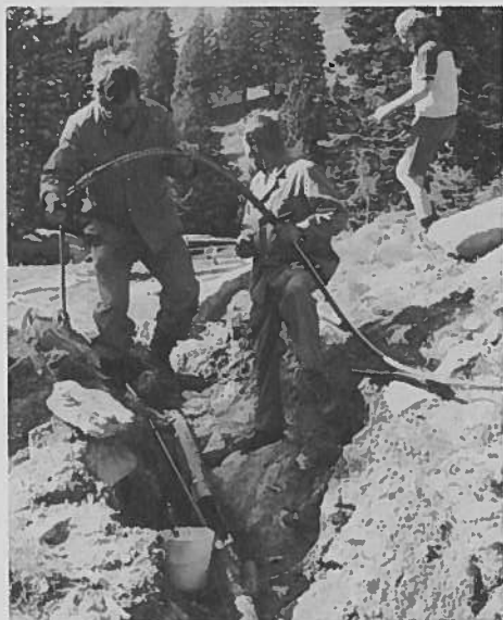
Die EW-Elite beim Kabeleinziehen
